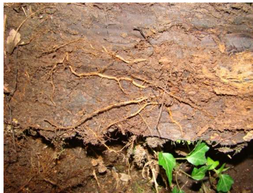
Figura 3. Troncos de un entramado vivo de madera en fase de descomposición muy avanzada (río Artía, Irún). Las raíces de la vegetación se desarrollan en el espacio anteriormente ocupado por los troncos y absorben sus nutrientes. Foto: Guillermo Tardío.
